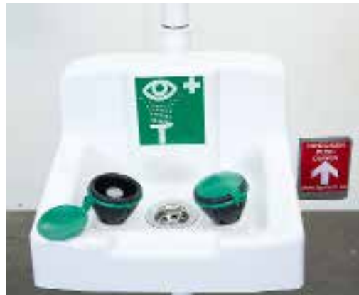
Oogdouche met opvangschaal en stofkappen Eye shower with bowl and dust cap
